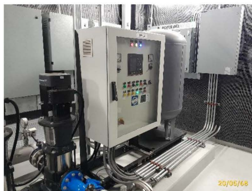
เครื่องจักรในระบบน้ำใช้ และแผงควบคุม (ดาดฟ้า)
